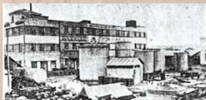
Inițial, fabrica Volman avea trei clădiri: cu un etaj, cu două etaje și cu trei etaje (în stânga). Ulterior, acestea au fost reconstruite, formând un complex mare cu trei etaje (în dreapta).
